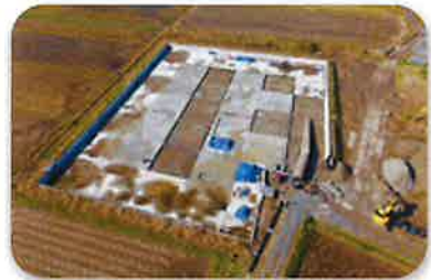
調整池工 施工状況
