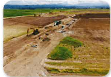
用排水路工 施工状況
