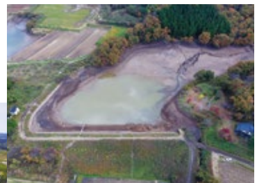
大沢ため池水抜き後
