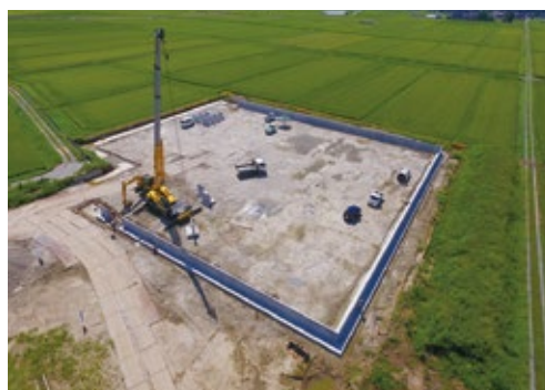
調整池工 施工状況
