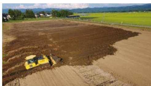
整地工 施工状況
