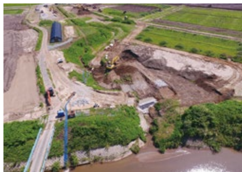
排水路工 施工状況
