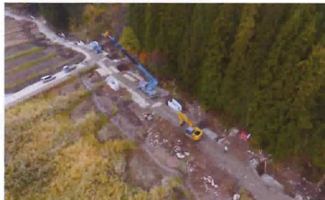
落差工設置状況
