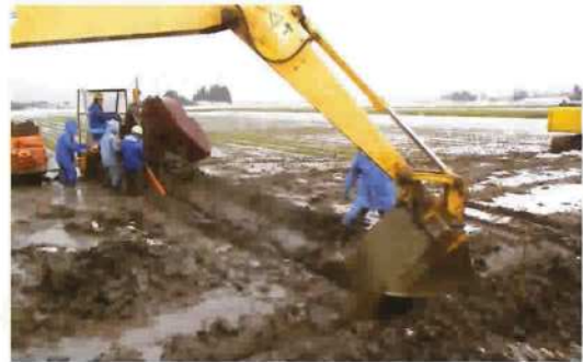
地下灌漑配管及び被覆材施工
