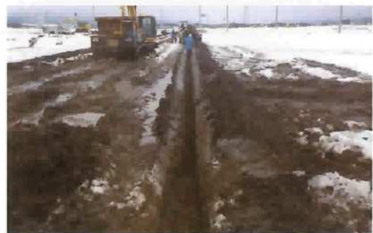
地下灌漑作業完了
