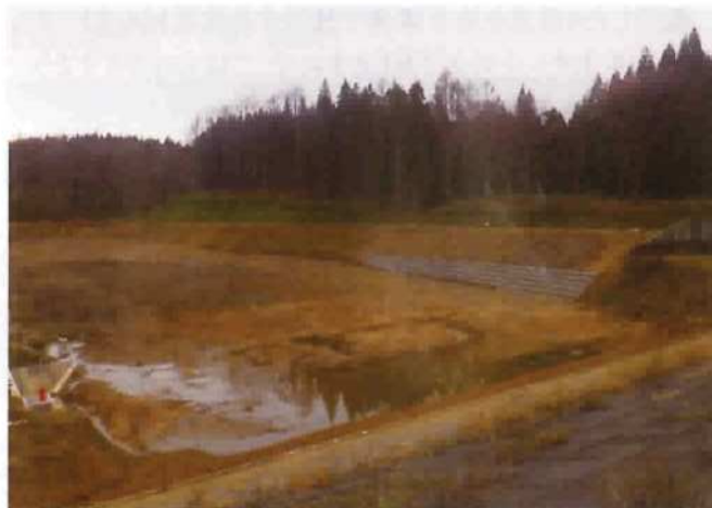
玉川第二ため池浚渫完了
