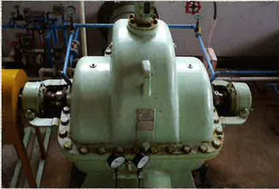
着工前(主ポンプ)
