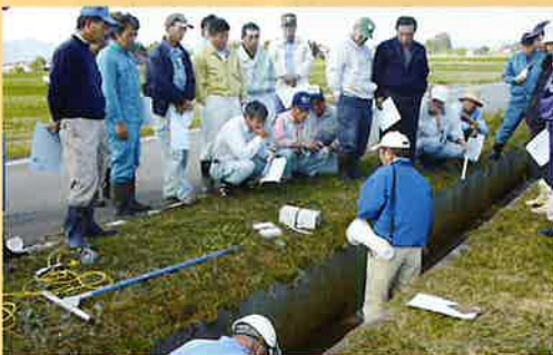
水路目地補修講習状況
